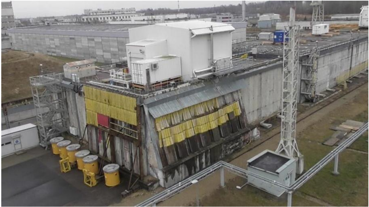
Рисунок 3-1. Здание хранения № 157 ИАЭС для эксплуатационных ТРО с установкой извлечения ТРО группы G3 (установка извлечения УИ-3)
