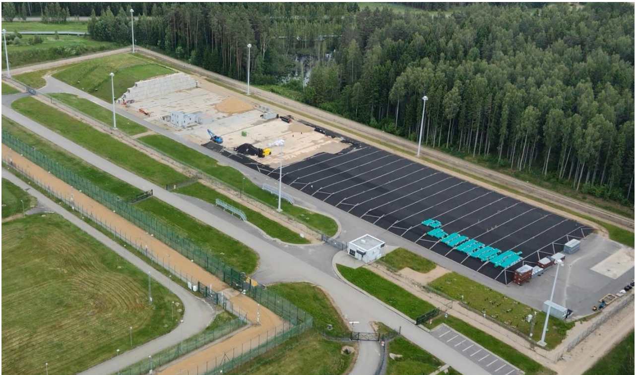
Рисунок 3-4. Модуль хранилища ОНУРО с инженерными барьерами и защитной стеной, сформированной после погрузки конкретной компанией
